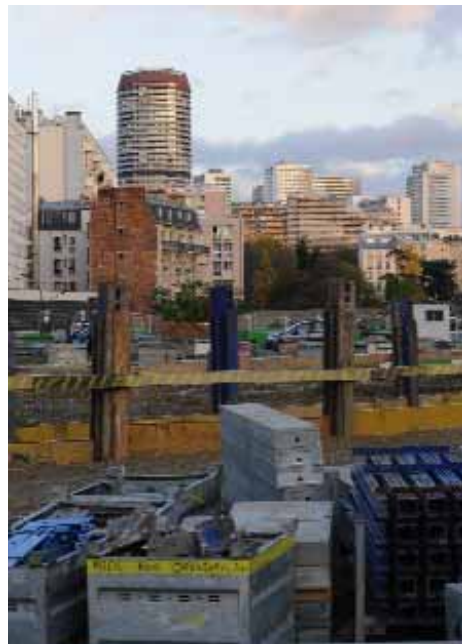
Chantier dans le XIII e arrondissement de Paris.
