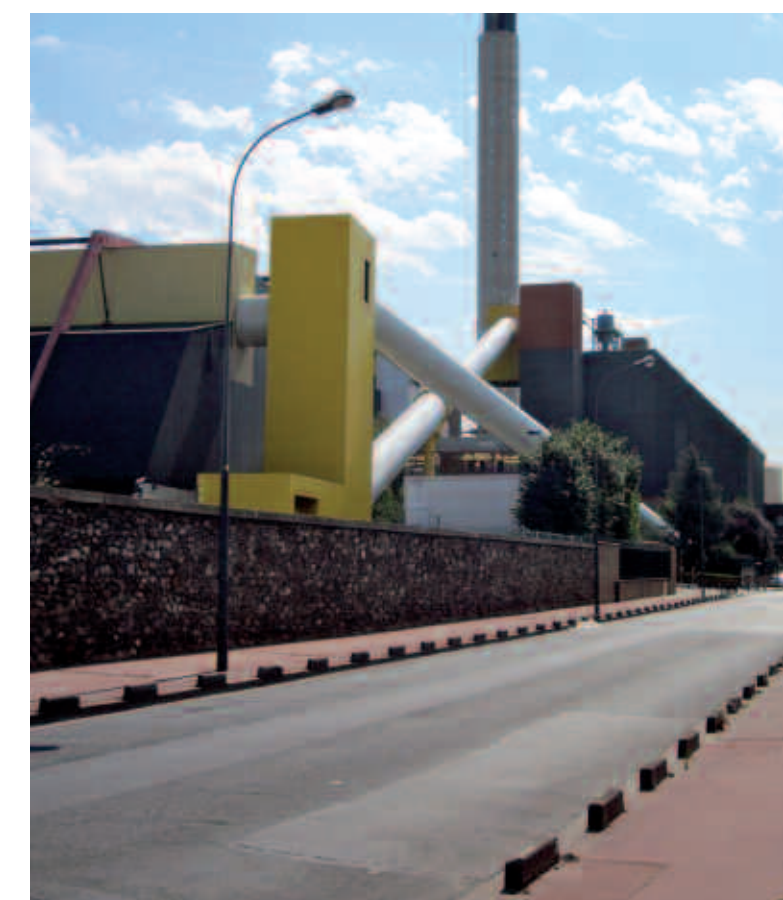
L'usine de chauffage urbain de Saint-Ouen.
