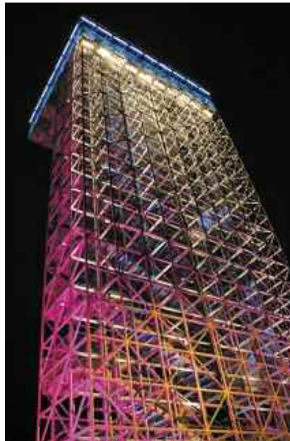
La Cité du design de Saint-Étienne dispose d'un véritable emblème avec sa tour-signal.
