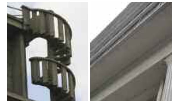
Détails d'un escalier de secours et d'une colonne d'immeuble d'habitation.
