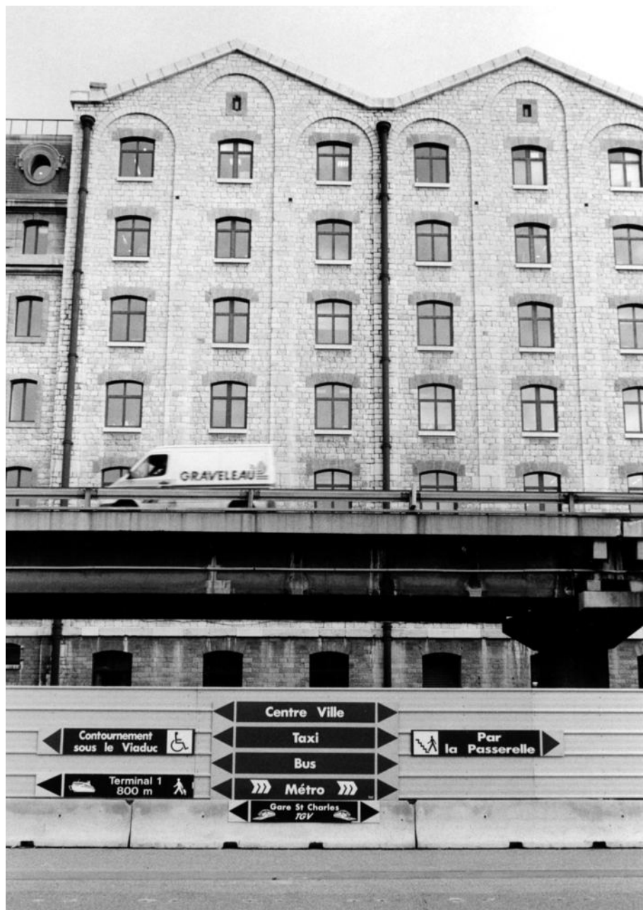
Les développements autour d'Euroméditerranée constituent l'une des étapes de la construction d'un espace métropolitain autour de Marseille.
