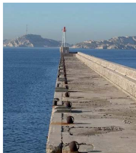
La Digue du Large
