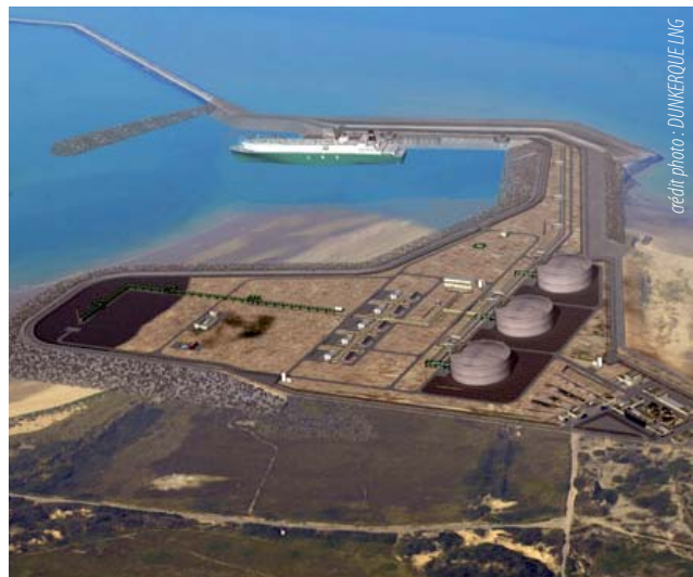
Dunkerque : Les travaux du terminal méthanier ont débuté
