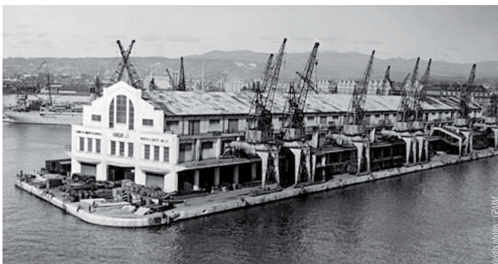
Le J1 avant réhabilitation
