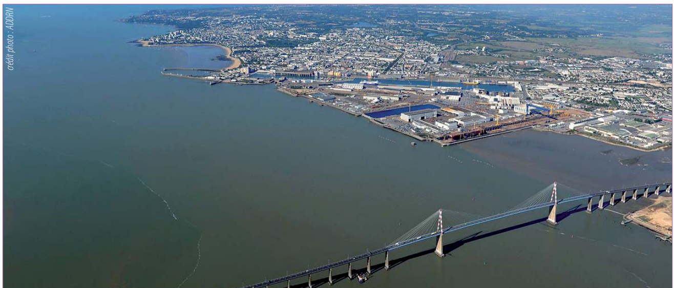
Le pont de Saint-Nazaire, trait d'union entre deux rives
