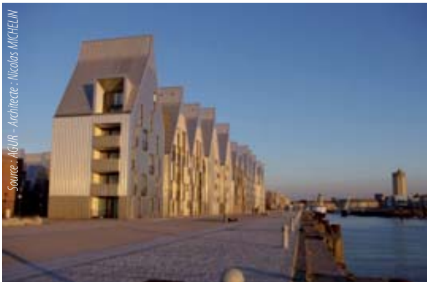
Projet Neptune à Dunkerque : immeubles en bord à quai de Nicolas Michelin
