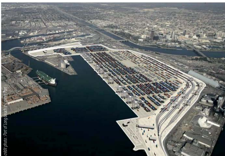
Port de Long Beach // Après
