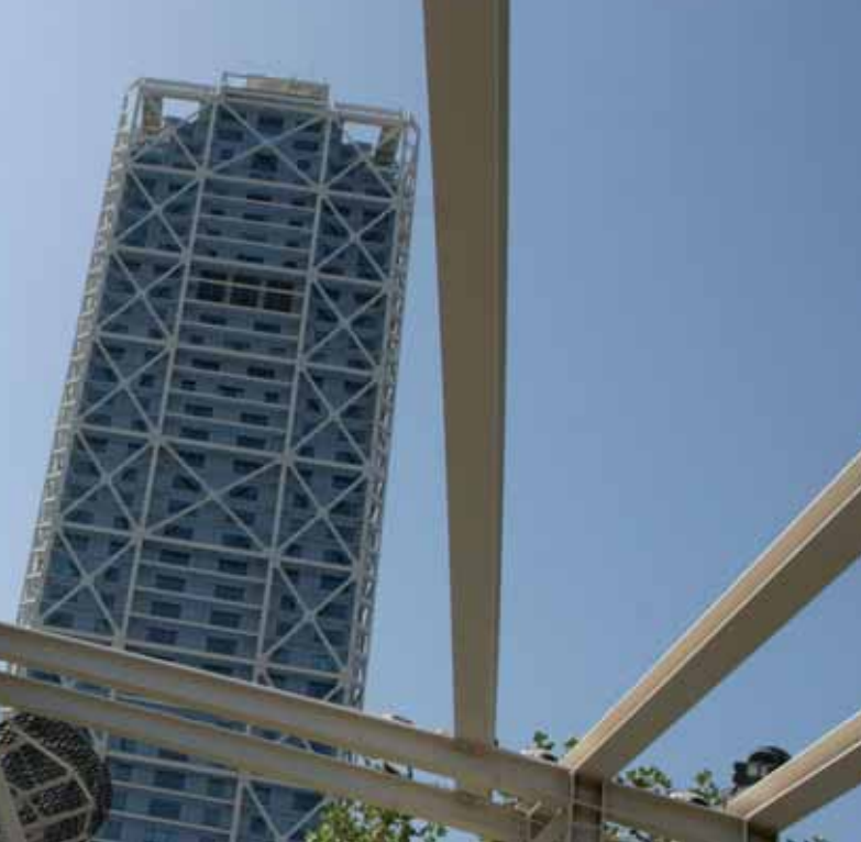
Barcelone (ci-dessus), le Grand Paris et Budapest (en bas, à g. et à dr.) sont confrontés tout autant à la nécessaire maîtrise de leur développement urbain/Barcelona (above), Greater Paris and Budapest (below, left and right) are all faced with the same need to control their urban development.
