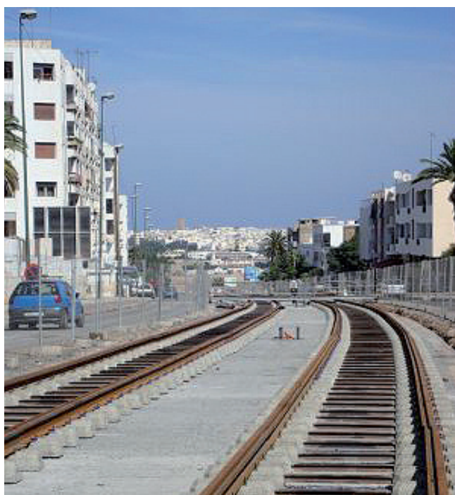
Le chantier du tramway de Rabat a un fort impact sur le fonctionnement quotidien de la capitale marocaine.
