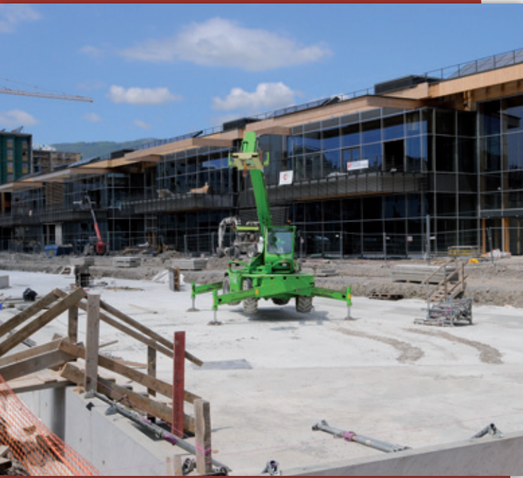
Les coûts des travaux d'aménagement ne sont pas sensiblement plus élevés du fait d'une conception durable.
