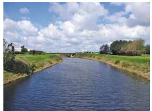
Berges du canal exutoire
