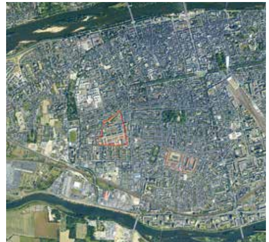
Situation du projet (Géocentre orthophoto 2012)
