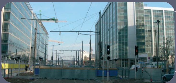
Un quartier d'affaires en construction: Euroméditerranée (Marseille) - crédit : agAM
