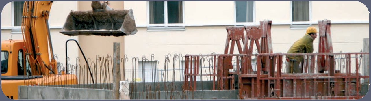
Travaux à Clairmarais à Reims - crédit : AUDRR
