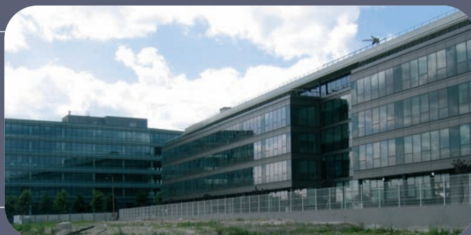
Immeuble Generali à Saint-Denis - crédit : laurif
