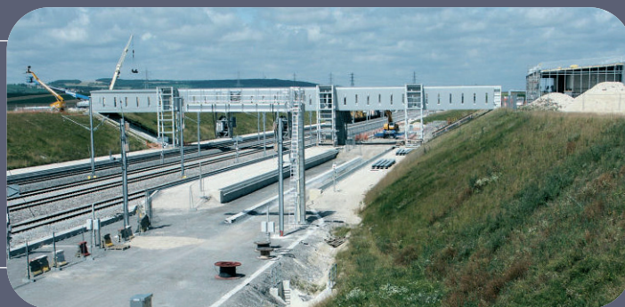
La gare de Bezannes en construction - crédit : AUDRR
