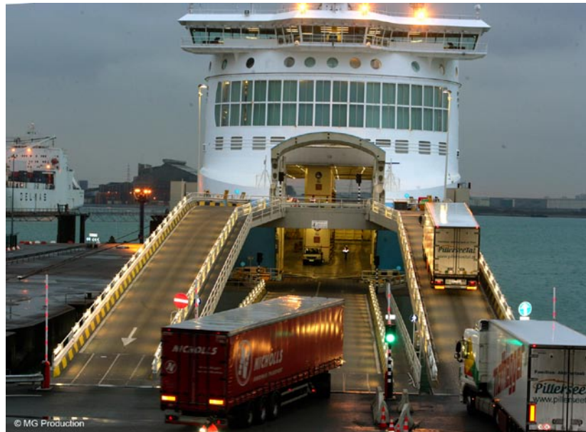
Dunkerque : Terminal roulier
