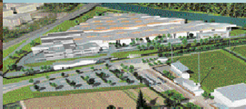
Dépôt Train 3 Glèze/Le Carpentier
