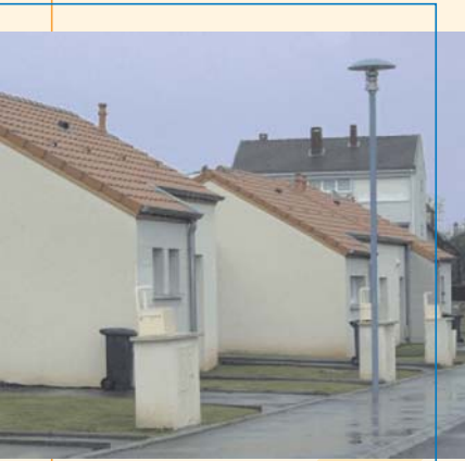
Opération OPAC à Gorcy : 8 logements réalisés
