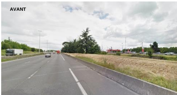
Vue de l'existant
