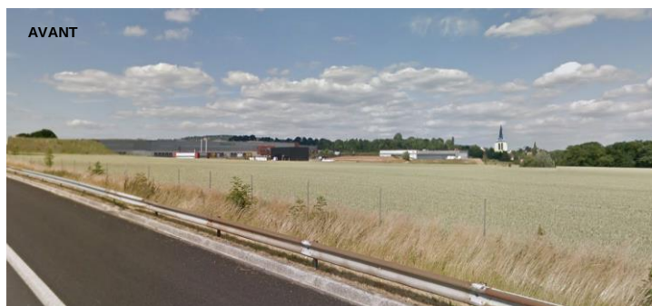
Vue de l'existant
