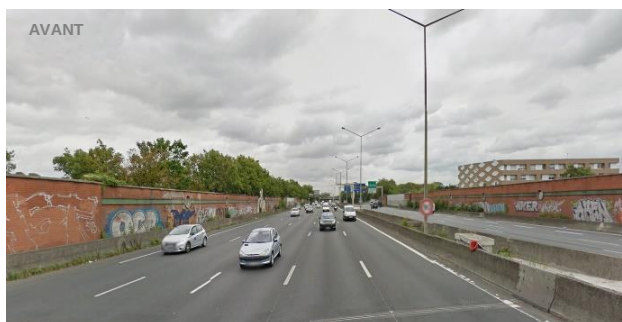
Vue de l'existant
