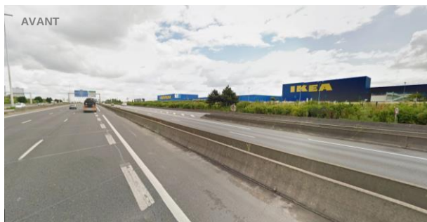
Vue de l'existant
