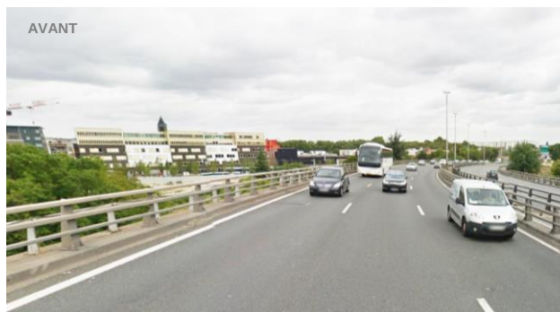
Vue de l'existant
