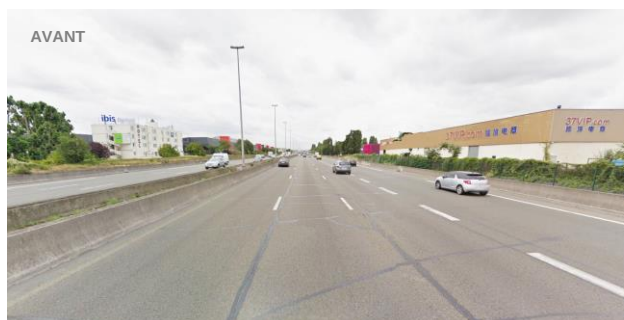
Vue de l'existant
