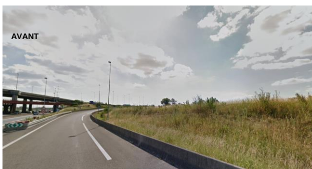
Vue de l'existant
