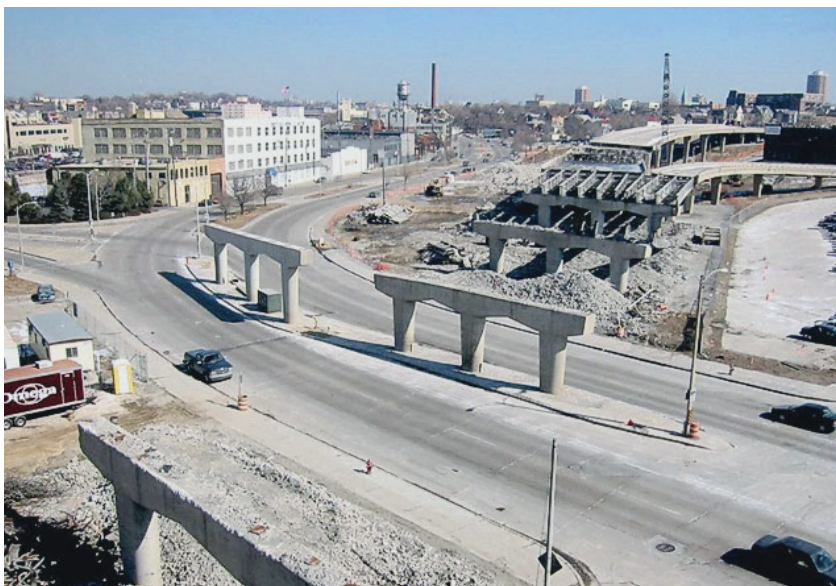
Chantier de démolition de la Park East Freeway entre 2002 et 2003. © Milwaukee Department of City Development
