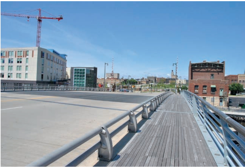
Le nouveau pont réalisé suite à la démolition de l'autoroute en prolongement de la McKinley Avenue. © P. Lecroart IAU îdF
