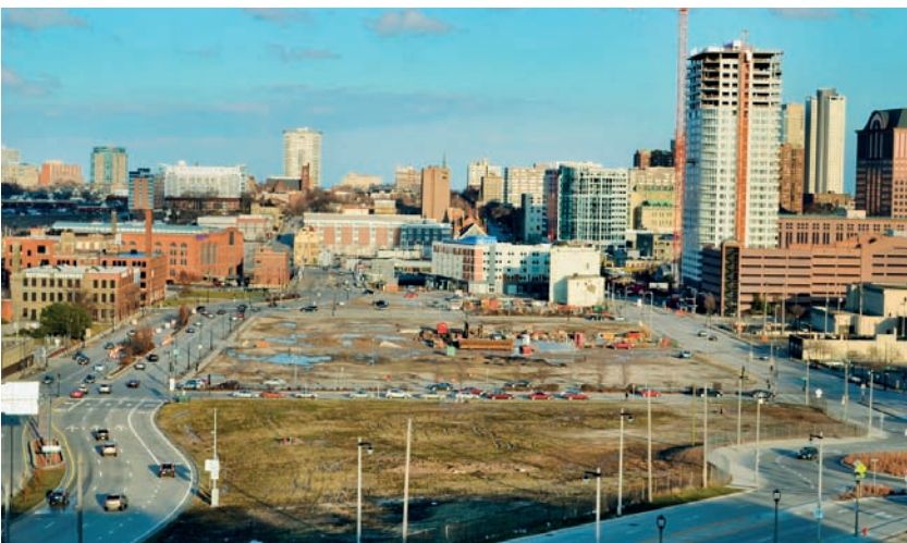
Le corridor de l'ex-autoroute Park East se construit peu à peu. À droite la McKinley Avenue ; à gauche, la tour The Moderne en construction en 2012. © Urban Milwaukee - DR
