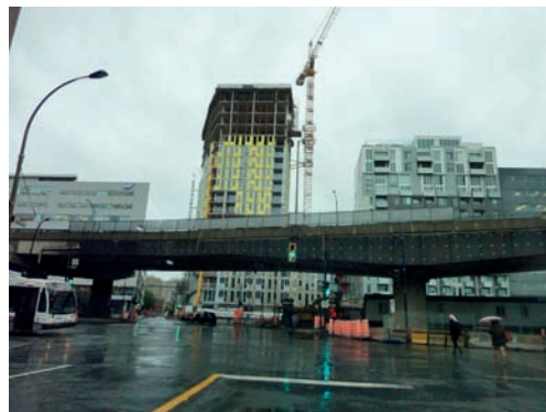
Les abords de l'autoroute se densifient par anticipation du projet. Nouveaux condominiums en construction en 2014. © P. Lecroart IAU îdF
