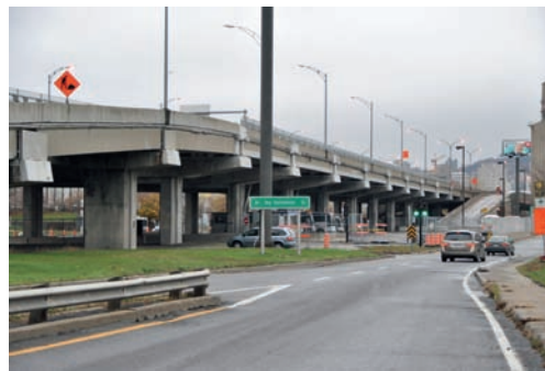
Au sud du bassin Peel, l'autoroute est de nouveau en viaduc. Le projet initial prévoyait de transformer ce tronçon en phase 3. © P. Lecroart IAU îdF
