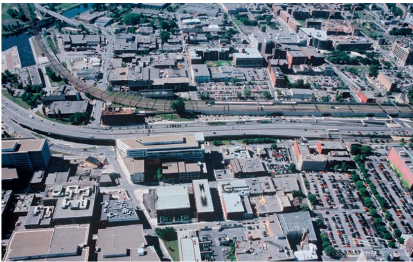
L'autoroute Bonaventure est une forte coupure urbaine au sud de Montréal. © Société du Havre de Montréal
