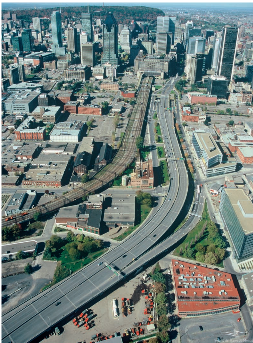
La voie ferrée en viaduc renforce l'effet de coupure créée par l'autoroute en entrée de ville. © Société du Havre de Montréal
