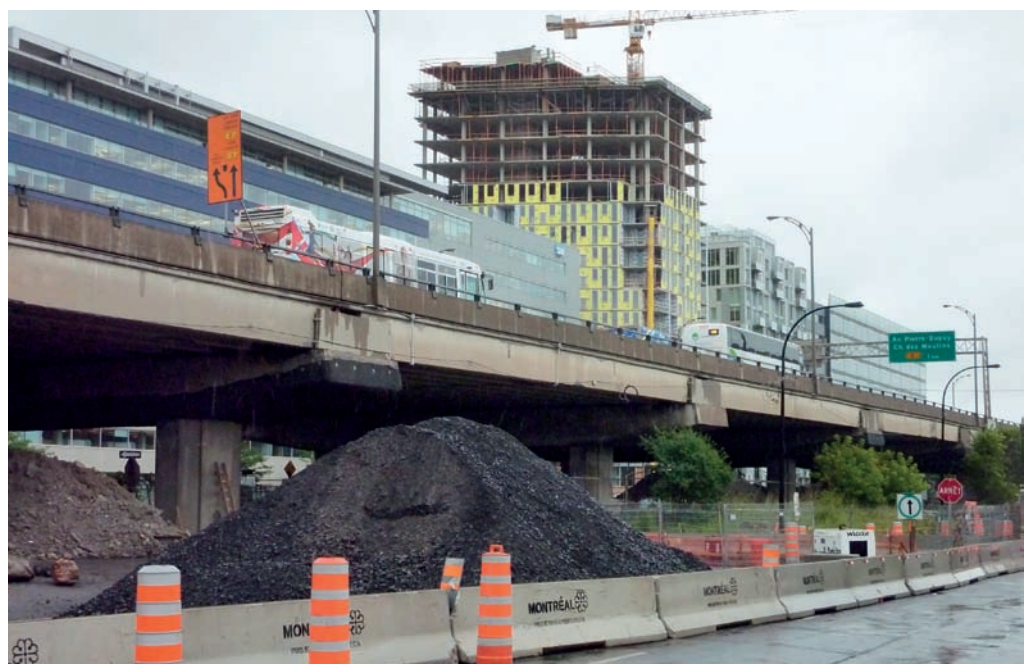
Le chantier de transformation de l'autoroute s'effectue sans interruption du trafic. © P. Lecroart IAU idF
