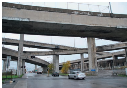
... L'échangeur Turcot, qui relie les autoroutes A-15, A-20 et A-720, est actuellement en reconstruction. ... Ce chantier de 3,7 milliards de dollars devrait s'achever en 2020. ... © P. Lacroart IAU idF
