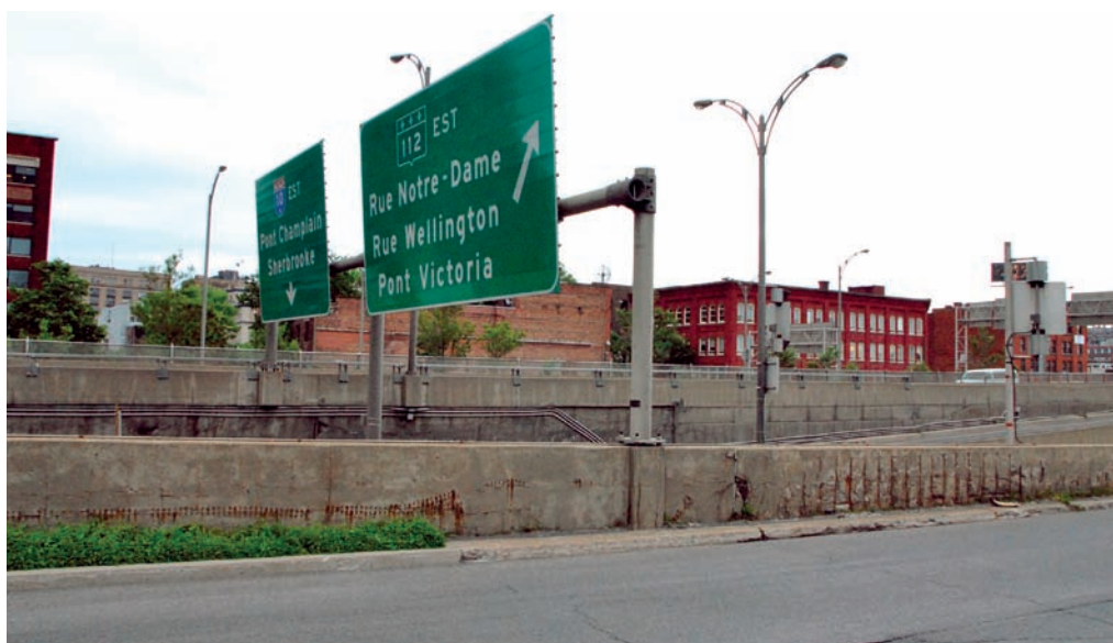
Les rampes d'accès entre les autoroutes Bonaventure et Ville-Marie forment une barrière infranchissable. © P. Lecroart IAU idF
