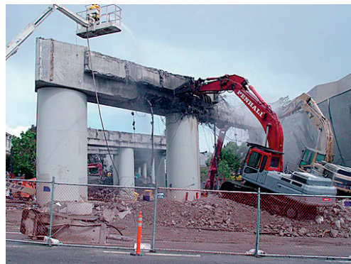
Après des années de débat, les travaux de démolition de la Central Freeway en 2003. © Chris Carlsson
