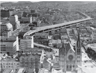
La section terminale du viaduc de la Central Freeway en 1965 (vue prise vers le Sud). © San Francisco History Center, San Francisco Public Library
