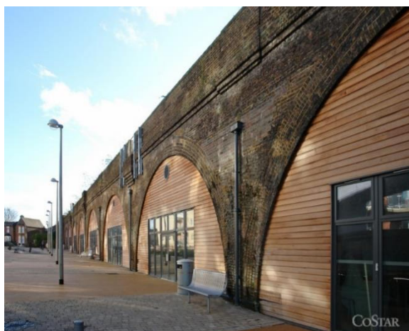
Londres - South Harrow Viaduct
