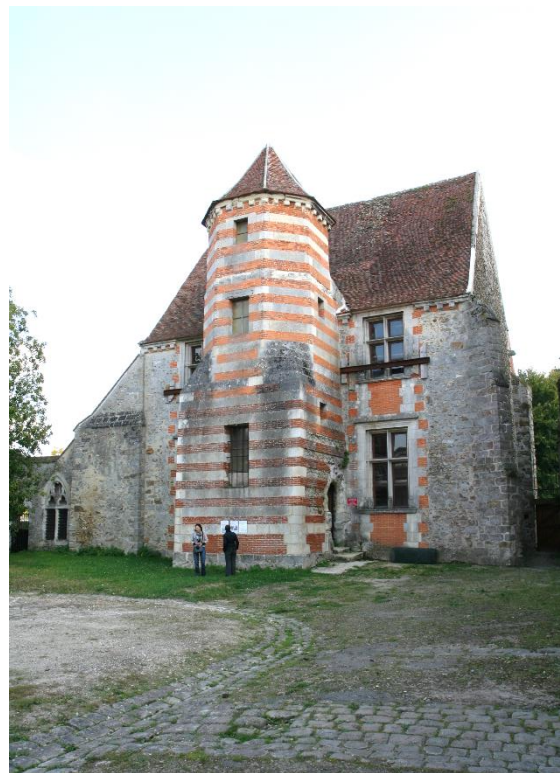
Commanderie des Templiers, vue depuis l'intérieur de la cour, Coulommiers
