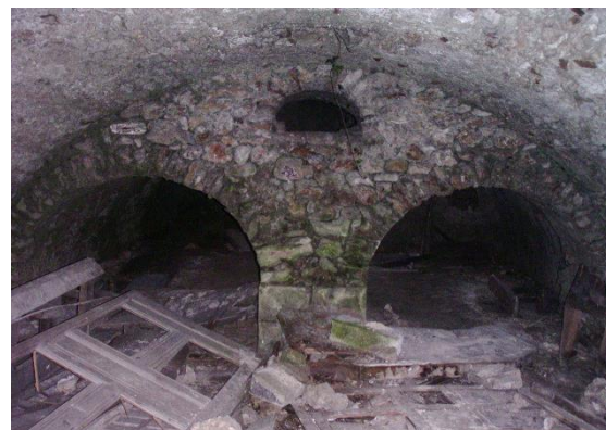
Souterrain abandonné, Crécy-la-Chapelle
