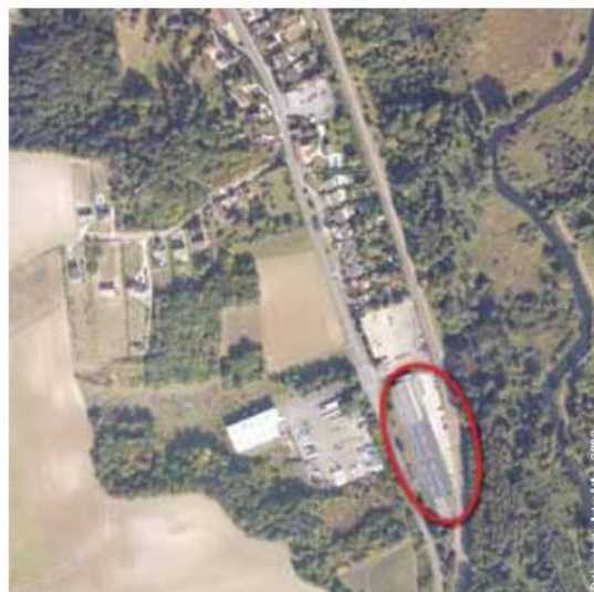
Le centre artisanal intercommunal Jean-Michel Daudu à Prunay-sur-Essonne (PNR du Gâtinais français) : vue aérienne du site de l'opération
