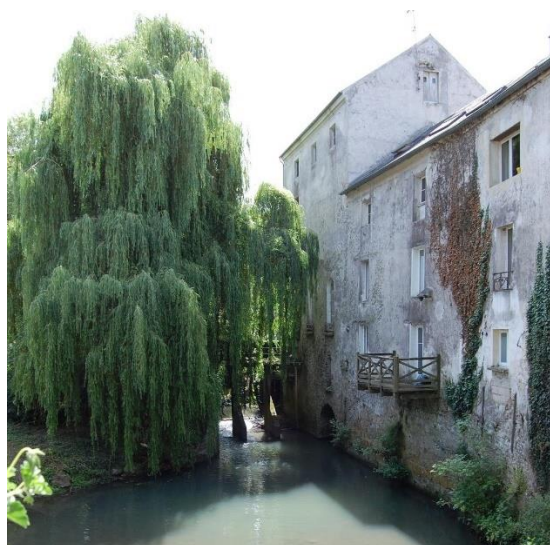
Ancien moulin de la Celle-sur-Morin, infranchissable par les poissons mais de valeur historique
