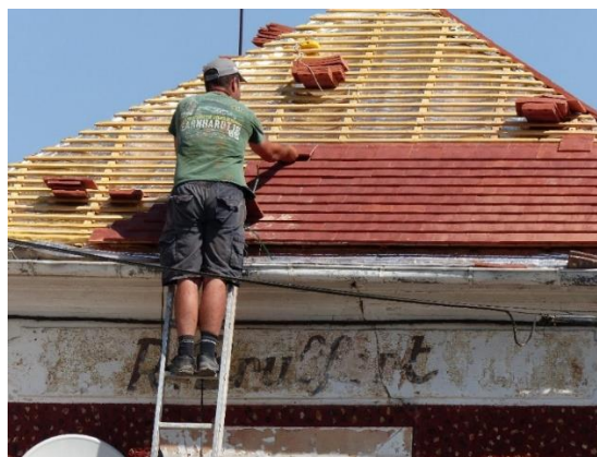
Pose d'une couverture de tuiles plates sur liteaux à Saint-Cyr-sur-Morin
