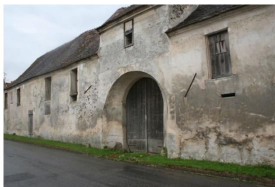
Grand corps de ferme à cour fermée
