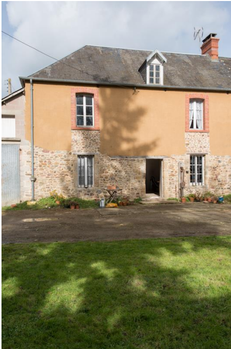
Les maisons en terre, construites selon la technique de la bauge, sont des constructions traditionnelles de la Manche, plus particulièrement des marais du Cotentin et du Bessin. Celle de Thérèse date de 1742.
