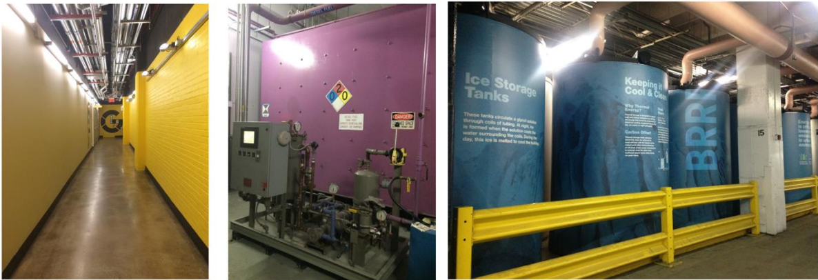
Figure 25. Intérieur du 111 8th avenue. Avec cuve de fioul et stockage thermique. Crédit =©Cécile Diguet et Fanny Lopez, 2018.
