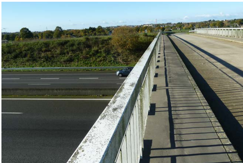
Passage sur l'A84 (Cesson-Sévigné)
