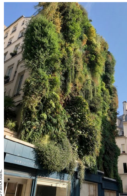
Mur végétal, rue d'Aboukir, Paris (2 ème arr.).
