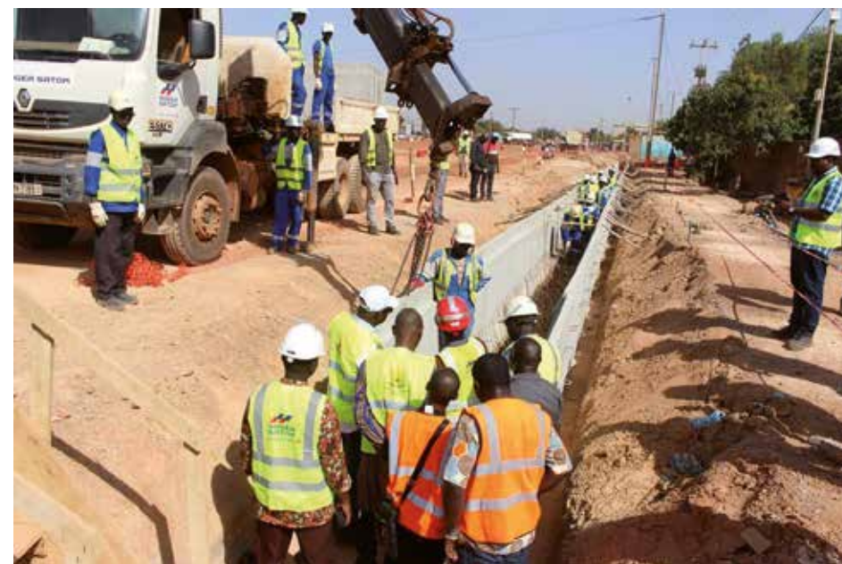
Chantier de construction d'un canal à Ouagadougou, Burkina Faso. © Ville de Ouagadougou.
