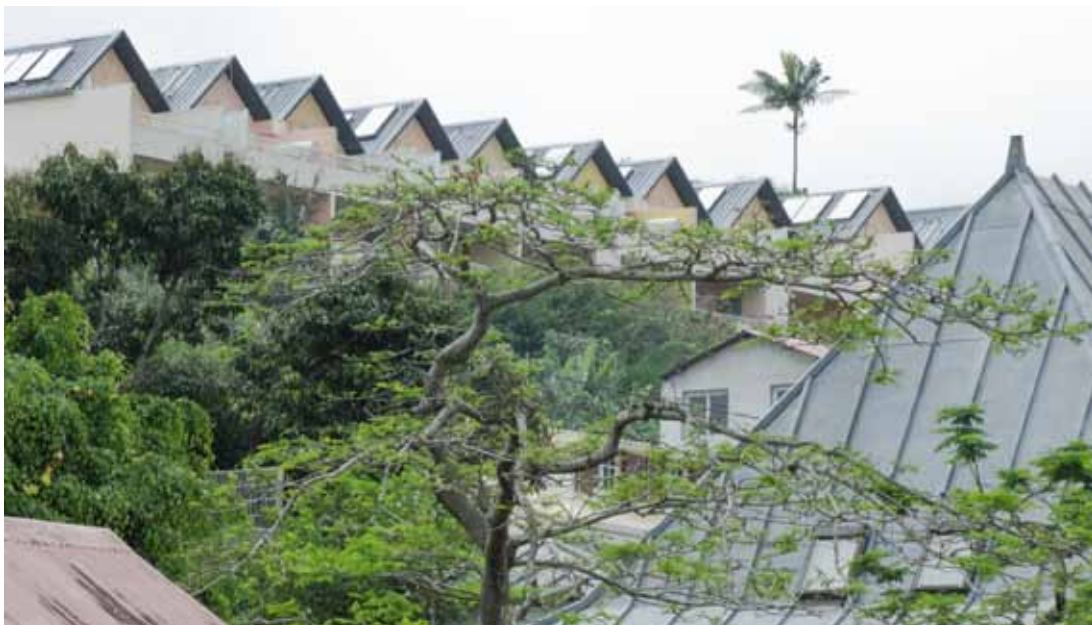
Logements collectifs - Ile de La Réunion
