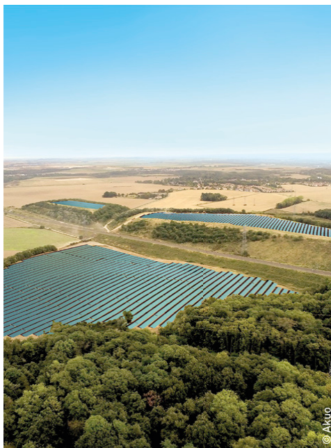
Centrale solaire photovoltaïque
