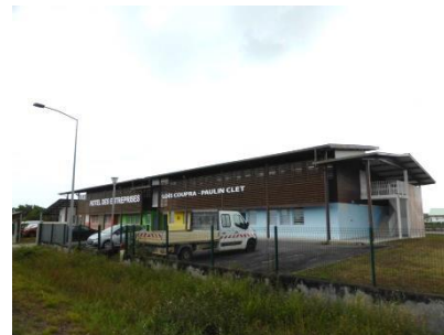
Hôtel des entreprises dans la zone Entrée sud de Sinnamary (Sinnamary)
