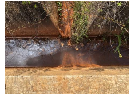
Fossé béton dans la zone Saint-Georges (Saint-Georges de l'Oyapock)
