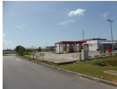
Station-service dans la zone Coltery (Cayenne)
