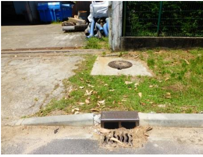
Grille avaloir et regard dans la zone Soula 2 (Macouria)
