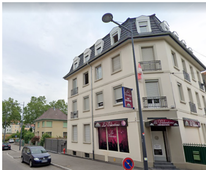
Rue du tunnel , Mulhouse - Dornach
