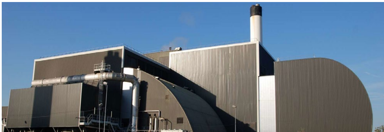
Usine de valorisation énergétique de Villejean (Rennes).
