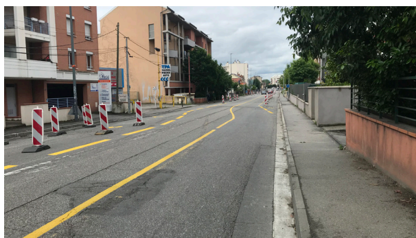
Aménagements cyclables temporaires boulevard Silvio Trentin
