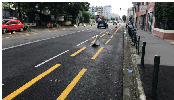
Aménagements cyclables temporaires avenue Jean-Rieux
