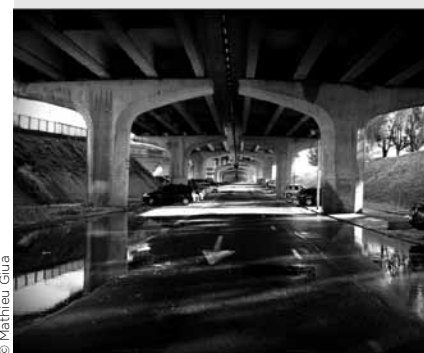
Sous l'autoroute A10.
