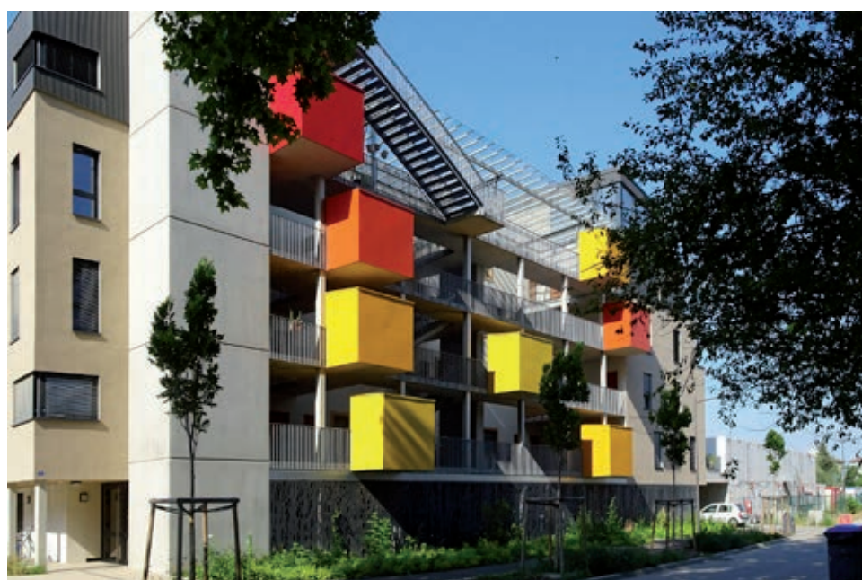
K'hutte (immeuble construit en autopromotion), quartier de Cronembourg, Strasbourg
