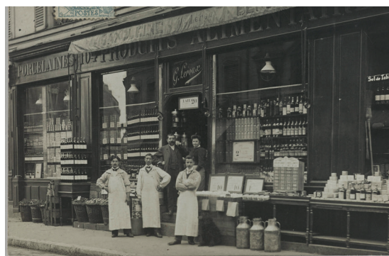
Boutiques parisiennes. Épicerie, négociant en vins. Produits alimentaires, Maison G. Leroux, 104, rue Boileau (16 e arr.), Bibliothèque historique de la ville de Paris.
