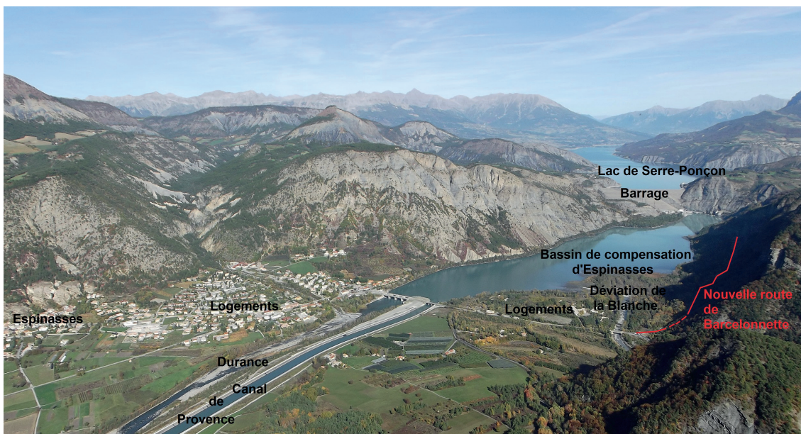
L'organisation du barrage de Serre-Ponçon, Étienne Baudon, 2013.
