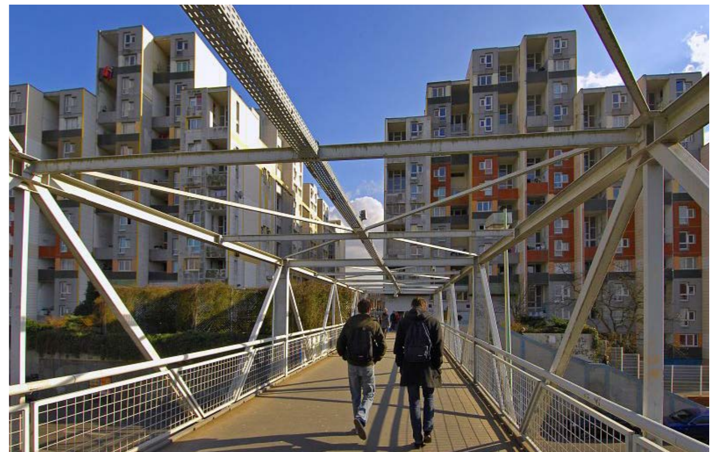
Pont-de-Bois à Villeneuve d'Ascq © MEL
