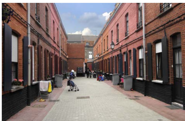
Cour Sénelar rue de l'Épeule à Roubaix © MEL
