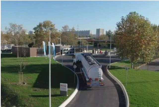
Station GNV au niveau de la plateforme logistique de Gennevilliers, ouverte en août 2020.
