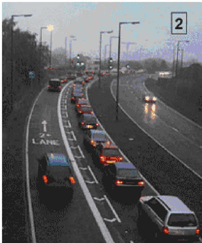
La voie VOM du Stanningley Bypass (A647) en entrée de Leeds © Leeds City Council
