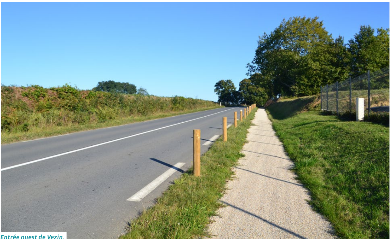
Entrée ouest de Vezin.
