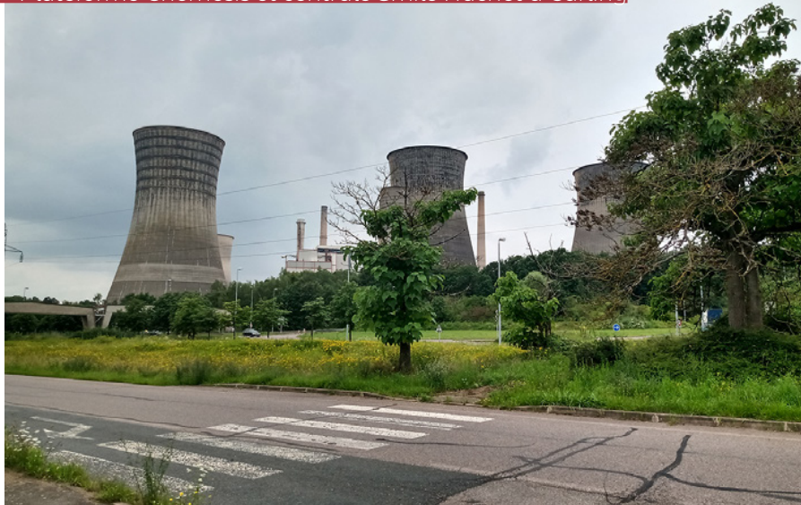
Plateforme Chemesis et centrale Emile Huchet à Carling
