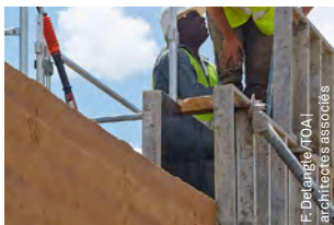
Mur en pisé sur le chantier de l'école Miriam-Mabeka, à Nanterre.
