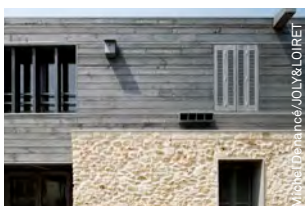
Mur en pierres (grès) de la Maison du Parc naturel régional du Gâtinais français.
