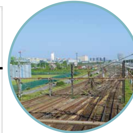
A. Le faisceau ferroviaire vers Euralille
