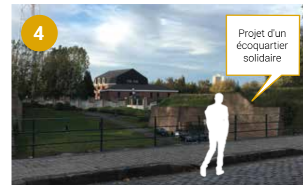
Anciens remparts en proximité de la porte de Gand
