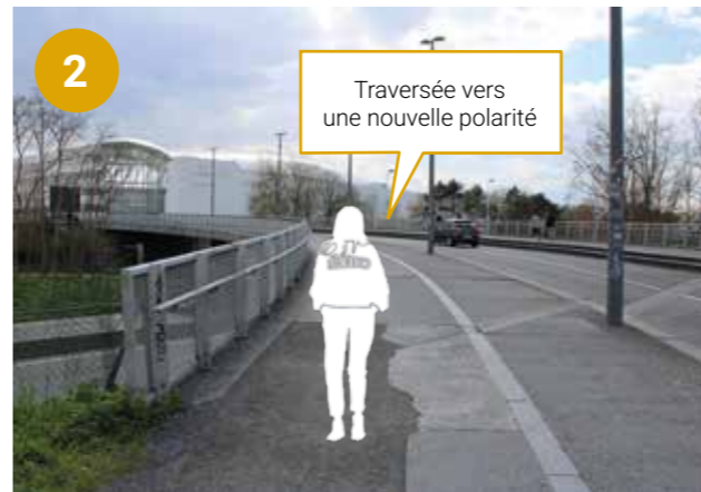
Pont Rue du Faubourg des Postes
