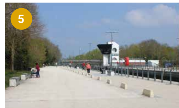
Écluse du Grand Carré
