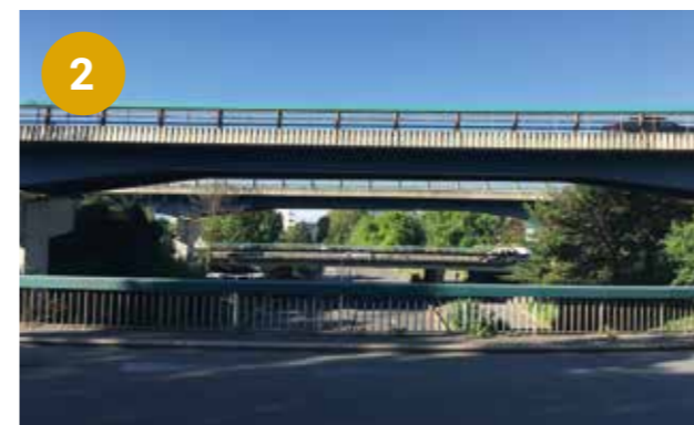
Carrefour Pasteur en direction de l'avenue de la République
