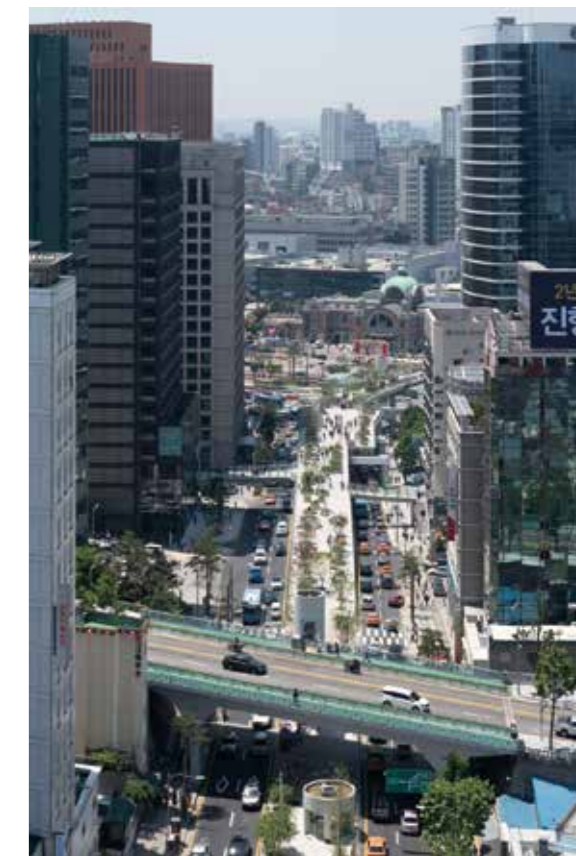
Photos du projet réalisé
