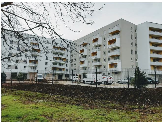
Le jardin d'Edo, résidence services privée en construction à Mulhouse
