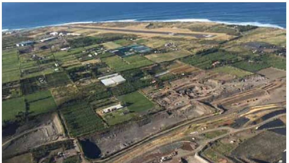
Vue aérienne de l'ISDND - Pierrefond
