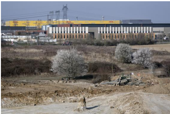
ZAC Aerolians – Aménagement de zones logistiques à proximité immédiate de l'aéroport CDG © Pierre-Yves Brunaud
