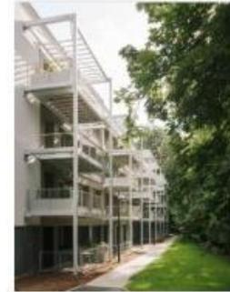
Réhabilitation de 5 façades pour améliorer la performance thermique du bâtiment et créer une nouvelle écriture architecturale. Couplage rénovation thermique / qualité d'usage : le projet comprend la création de loggias offrant aux locataires une pièce en plus, la réalisation de logements neufs au RDC, de nouvelles parties communes et halles accessibles aux PMR.
