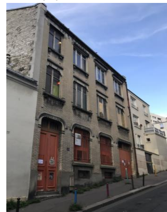
La Grande Coco (avant travaux), Paris Crédit Alienor Heil / L'Institut Paris Region
