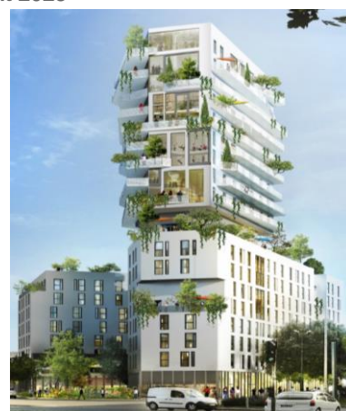
Linkcity, Castro Denissof architectes, Noisy-le-Sec Crédit Castro Denissof
