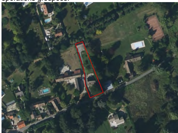
Habitat individuel hétérogène, pavillon à l'interstice de 2 anciennes fermes transformées en maisons individuelles – commune de Gambais (78) – Emprise foncière : 1 172 m 2 ; COS = 0,21 ; CES : 0,15 ; densité résidentielle : 8 lgt/ha.
