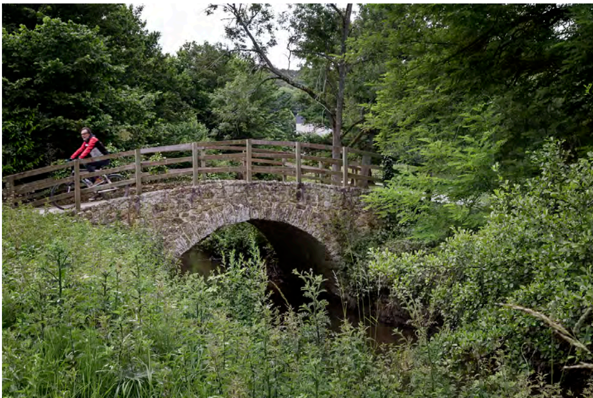
Arche piétonne et cyclable au-dessus de l'Yvette, entre Bures-sur-Yvette et Gif-sur-Yvette Crédits : Pierre-Yves Brunaud, L'Institut Paris Region
