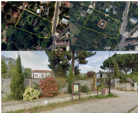
Opération réalisée en 2015 de démolition-reconstruction d'un habitat individuel – avenue Léon Crète – impasse du Bois Ivon, commune de Méré – Emprise foncière : 3 273 m 2
