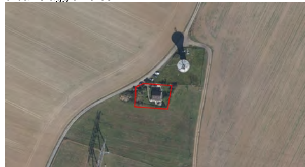
Pavillon isolé en plein champs entre une ligne haute tension et un château d'eau – commune de Bullion – Emprise foncière : 870 m 2 env. ; COS = 0.14 ; CES : 0.09 ; densité résidentielle : 12 lgt/ha.
