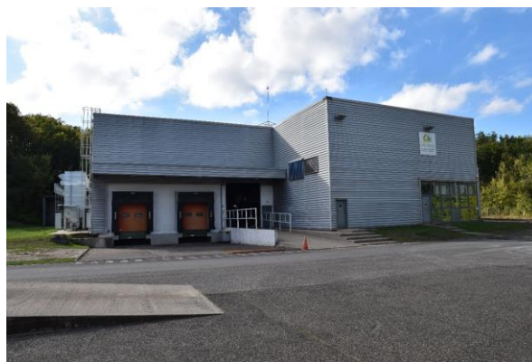
Le site de l'usine de la société nouvelle Gâtichanvre, à Prunay-sur-Essonne,
