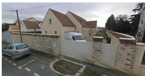
Opération réalisée en 2007-2008 de démolition-reconstruction et mutation d'une parcelle d'activité avec division parcellaire pour la création de 2 logements individuels
