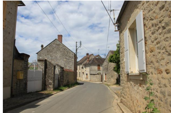
Village linéaire en ordre serré, à Noisy-sur-École
