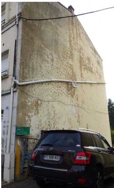
Des cicatrices urbaines qui ponctuent le centre-ville
