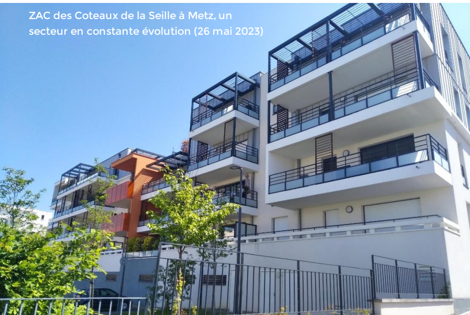
À Metz, près de la gare, le programme Renaissance actuellement en construction remplacera l'ancien garage Opel (26 mai 2023)
