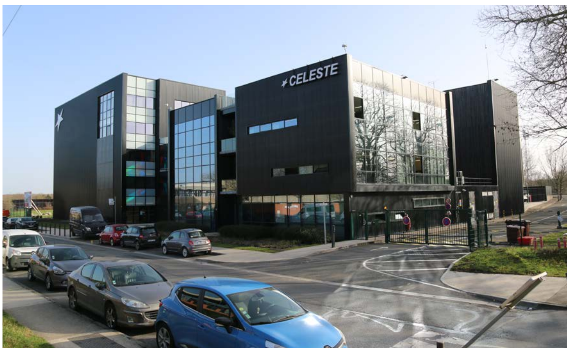
Data center « Marilyn » de Céleste, situé dans la Cité Descartes à Champs-sur-Marne. Source : L'Institut Paris Region, 2021.
