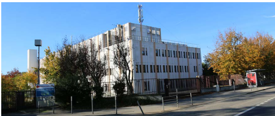
Parmi les data centers franciliens, des anciens bâtiments de télécom comme à Vélizy-Villacoublay (ci-dessus), de nouvelles constructions comme à Marcoussis (p. 17 haut), et des bâtiments de bureaux transformés comme à Lognes (p. 17 bas, site désormais fermé). Source : L'Institut Paris Region, 2021.
