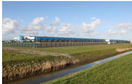
À Hollands Kroon, tout au nord de la province de Hollande-Septentrionale sont installés de data centers hyperscales, comme celui-ci de Google. Plusieurs autres de Microsoft sont situés à proximité.
