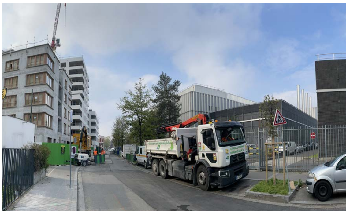
À Saint-Denis, des logements en construction font face à deux data centers de Digital Realty (Interxion), implantés depuis la fin des années 2010. Source : L'Institut Paris Region, 2023.
