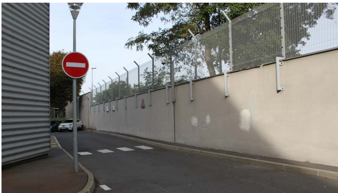
Data center de Digital Realty (Interxion), rue du Rateau à La Courneuve (93). Source : L'Institut Paris Region, 2021.
