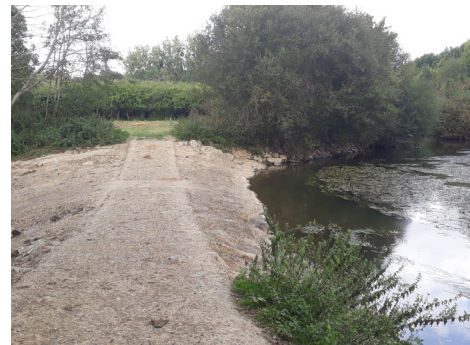
Digue en béton sur un bras de la Vilaine. © Audiar.
